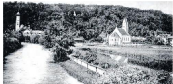
Historisches Foto: rechts die evangelische Kirche St. Michael – eine Mischung aus Jugendstil und Neoromanik, errichtet (1908/09); in der Mitte der Flobkanal; links die katholische Pfarrkirche St. Andreas, erbaut 1484 (Spätgotik), 1621–26 (Barock) umgestaltet.
